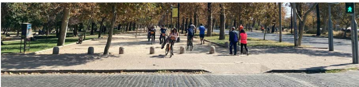
Figura 197. Fotografía de un dispositivo de rodado en el Parque Forestal frente a una vía adoquinada, en este caso el dispositivo no presenta terminación podotáctil adecuada para la ruta accesible. Fuente: archivo ONG Poloc 2023.
