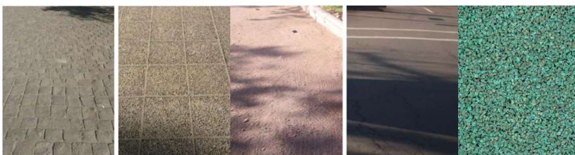
Figura 195. Fotografías de pavimentos existentes en el parque (de izquierda a derecha), adoquines en atrios y calzadas; baldosa tipo colonial color habano en aceras; maicillo en senderos; y asfalto en calzadas. Fuente: archivo ONG Poloc 2022. Fotografía de caucho drenante color verde en zonas de juego. Fuente: disponible en https://depositphotos.com/es/photos/piso-de-caucho.html , recuperada el 8 de mayo de 2022.
