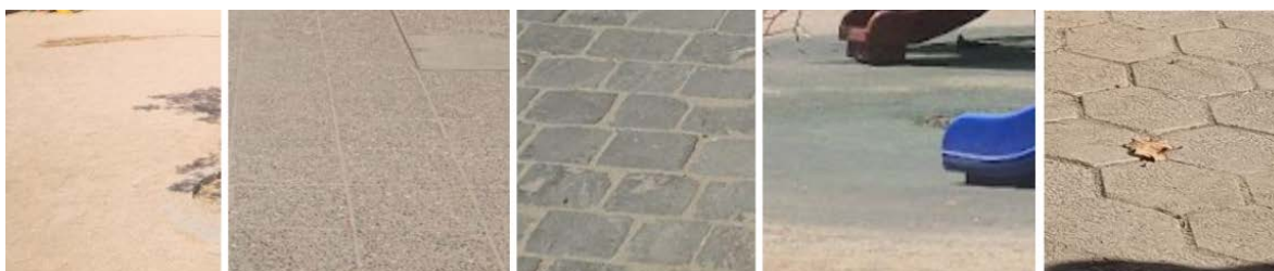
Figura 37. Fotografías de los pavimentos más representativos y con mayor presencia en el Parque Forestal, de izquierda a derecha: Maicillo, Baldosa colonial, Adoquines, Caucho y Baldosa hexagonal. Fuente: archivo ONG Poloc 2021 y 2023.
